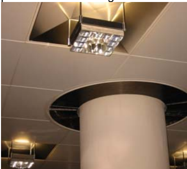
Detail: Säulen-Quellluftauslass
