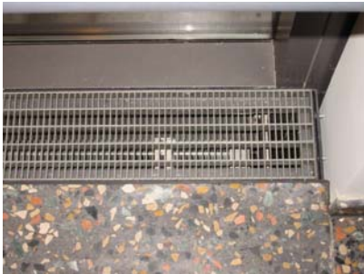
Detail: Konvektorabdeckung Treppenhaus
