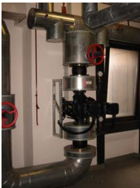
Hauptpumpen-Wärmeverteilung
