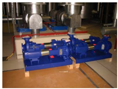
5. Schritt Einbindung der neuen Kaltwasserpumpen
