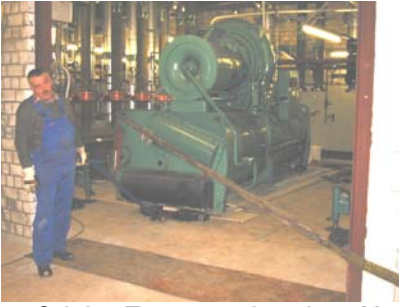
1. Schritt: Transport der alten Maschinen aus dem Gebäude
