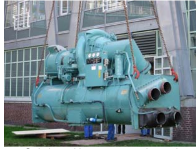
2. Schritt: Abtransport der alten Maschinen
