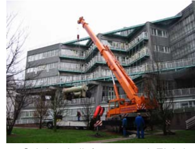
3. Schritt: Anlieferung und Einbringung der neuen Maschinen
