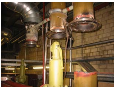
4. Schritt: Anbindung der neuen Maschinen an das bestehende Rohrnetz
