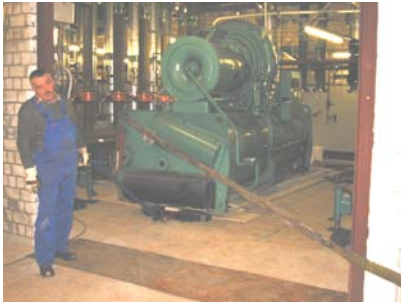
1. Schritt: Transport der alten Maschinen aus dem Gebäude
