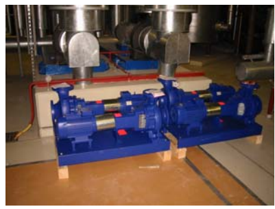
5. Schritt Einbindung der neuen Kaltwasserpumpen
