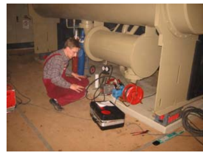
6. Schritt: Inbetriebnahme und Übergabe an den Bauherren
