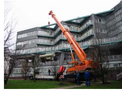
3. Schritt: Anlieferung und Einbringung der neuen Maschinen
