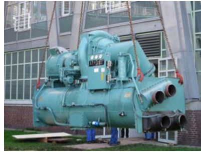
2. Schritt: Abtransport der alten Maschinen
