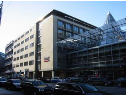
Bild: Außenansicht Gebäude A, B und C
