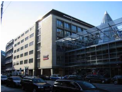
Bild: Außenansicht Gebäude A, B und C
