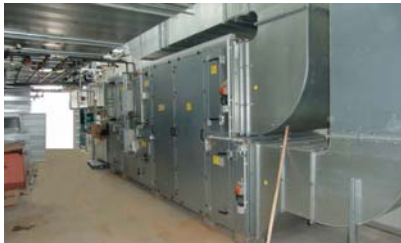
RLT-Anlage Dachaufbau
